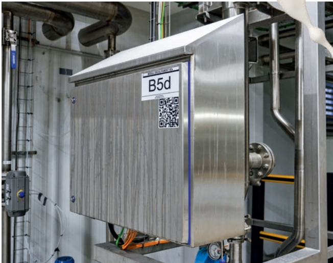
Vorteile der Rittal Edelstahlgehäuse im Hygienic Design: Dachneigung von 30 Grad nach vorne, glatte Oberfläche, rundum außenliegende spaltfreie Silikondichtung
